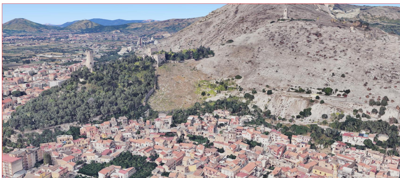
Figura 11. Bacino idrico Casmez – sulla sinistra i due imbocchi alle gallerie in cemento armato
